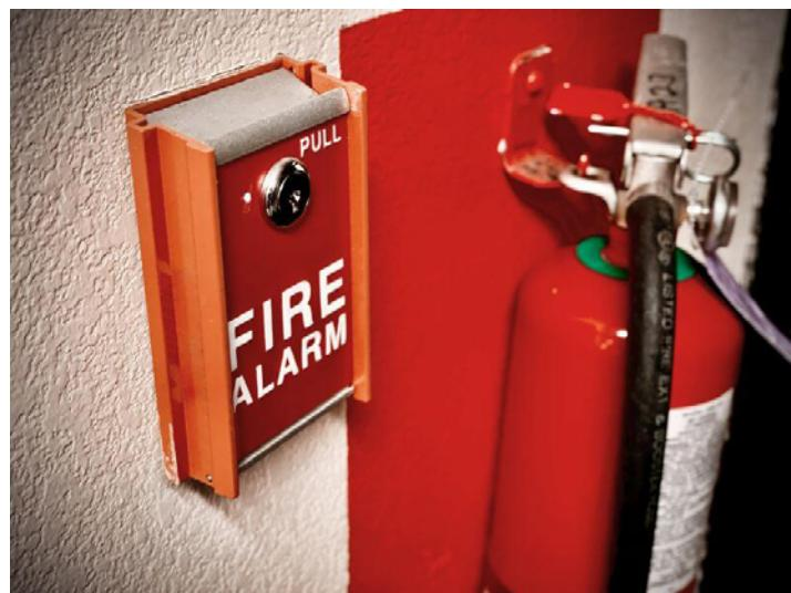
Su correcta selección, instalación y mantenimiento es fundamental. Un equipo inadecuado, mal ubicado o en malas condiciones puede generar una falsa sensación de seguridad y retrasar una respuesta efectiva, aumentando el riesgo para las personas y las instalaciones.
